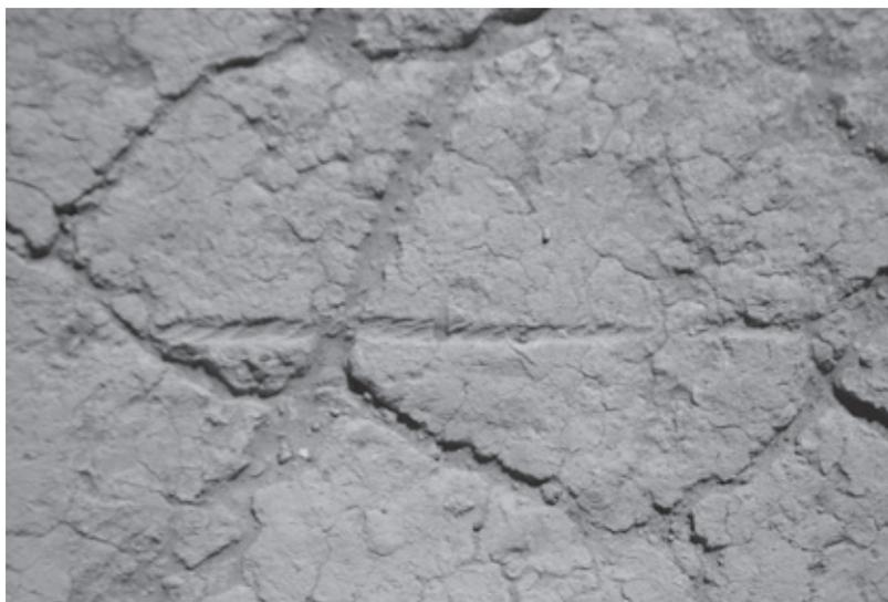
**Figura 13 – Impronta de línea de ajuste de construcción**
