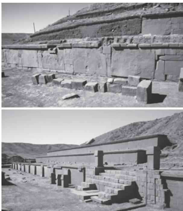
Figura 5 – La fachada occidental de Akapana con pilastras de andesita y cimientos de arenisca (© J. Janusek)
